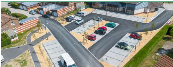
Parkings perméables Bois-en-Ardres
