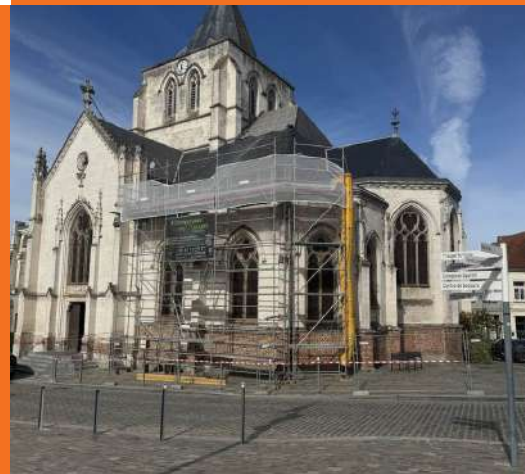
Remplacement du voligeage Église Notre-Dame de Grâce
