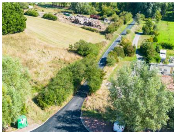
Réfection de la Chaussée Rue Duchatelle
