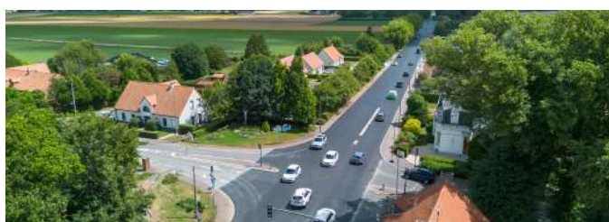
Réfection de la Chaussée - RD 943 du carrefour des Tilleuls à la Zone d'Activités
