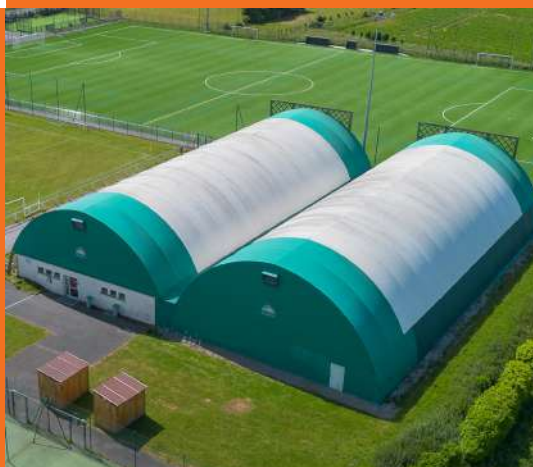
Remplacement de l'entoilage Courts couverts de Tennis
