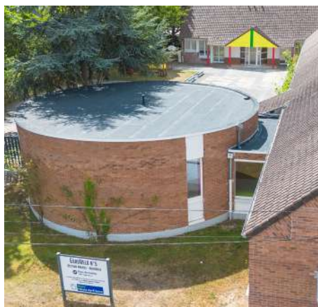
Rénovation de la toiture de la rotonde École Maternelle André Pruvot
