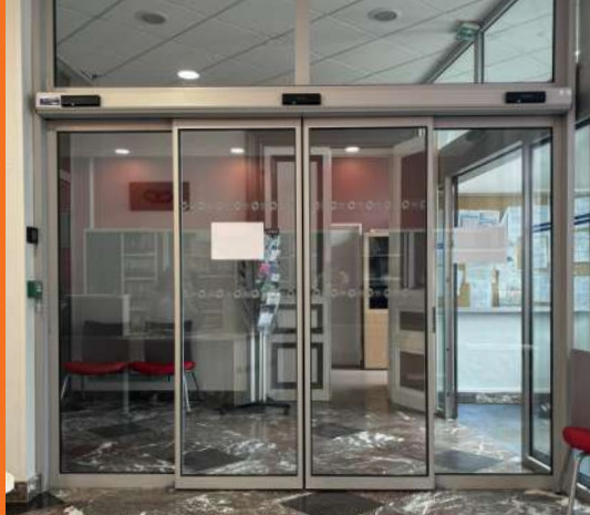
Installation du SAS à l'accueil de la Mairie
