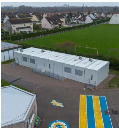
Installation des modulaires à l'École Pierre et Marie Curie
