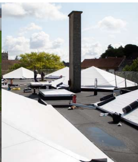
Réfection de la toiture de l'École Pierre et Marie Curie
