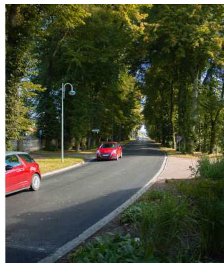
Réfection de la chaussée sur l'Avenue des Tilleuls
