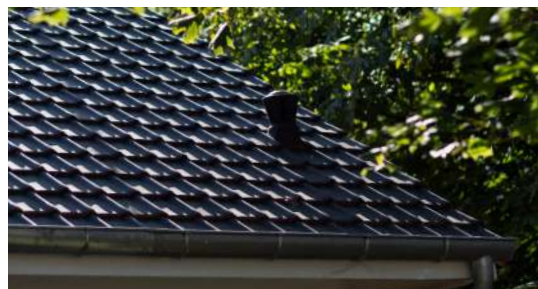
Réfection de la toiture de l'École Anne Frank
