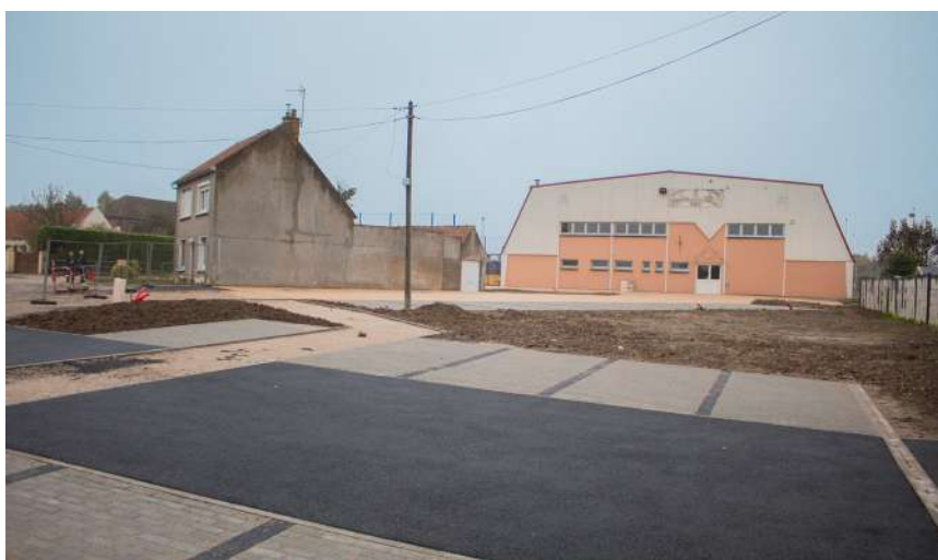
Installation de nouvelles places de parking à l'Écogymnase
