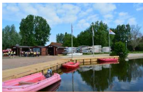
Rénovation du ponton de la Base Municipale de Loisirs
