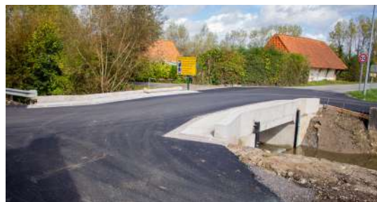
Rénovation du Pont Troué
