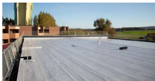
Réfection de la toiture de la Salle Albert Loquet
