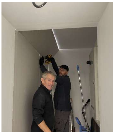
Mise aux normes de la Maison de Santé
