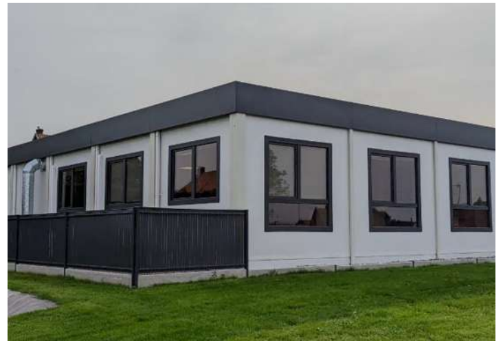
Installation de nouveaux modulaires pour l'École P&M Curie
