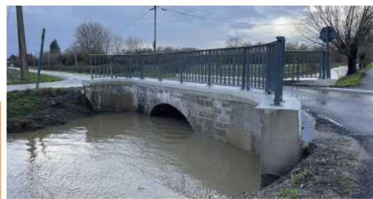
Rénovation du Pont à Cochons
