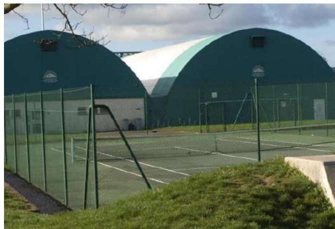
Remplacement de la toiture des courts couverts
