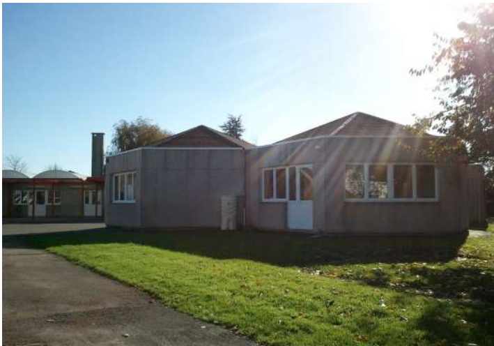
Remplacement de la sur-toiture des Écoles de Bois-en-Ardres
