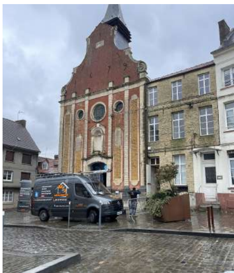
Travaux d'étanchéité de la Chapelle des Carnes
