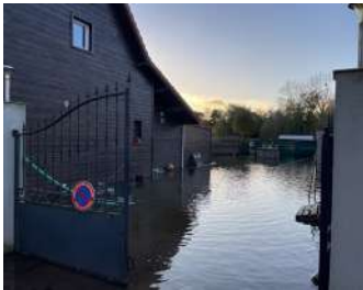
Inondation Avenue du Lac
