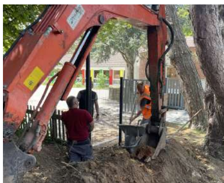
Installation de la clôture de l'École André Pruvot
