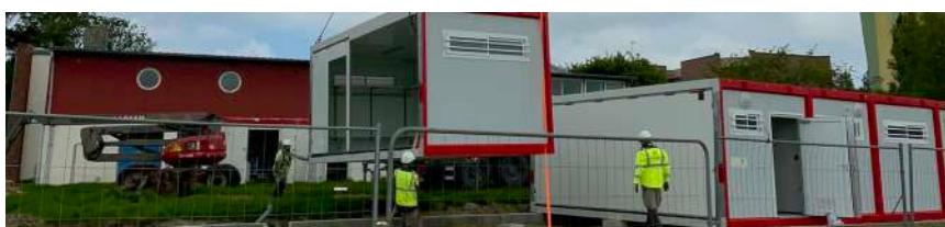
Installation des nouveaux vestiaires modulaires au Complexe Albert Loquet
