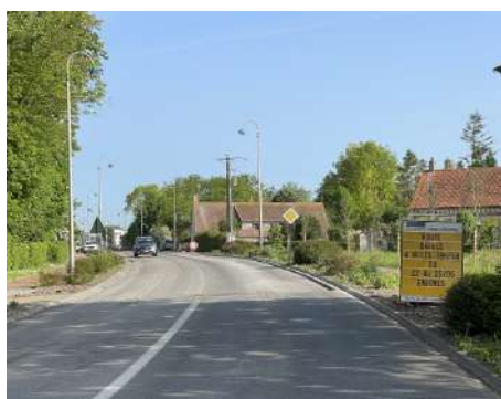
Réfection de la chaussée - Avenue de la Cense Hébron et du Rossignol
