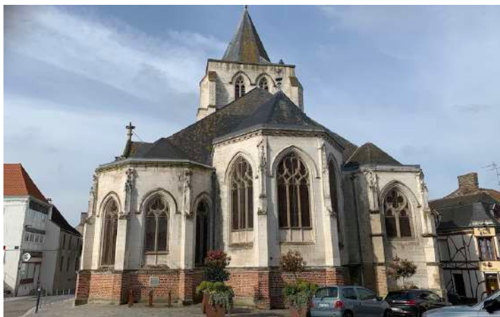
Travaux d'étanchéité de l'Église d'Ardres
