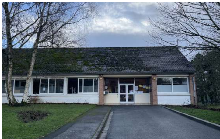
Remplacement de la toiture de l'École Anne Frank
